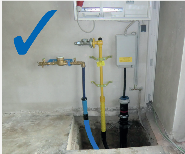
Abb. 1: Aussparung in der Bodenplatte
